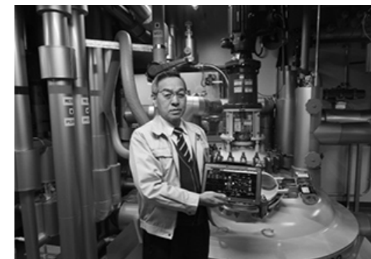
タブレット操作で自動化された新工場
