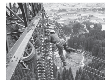
送電線上での作業風景
